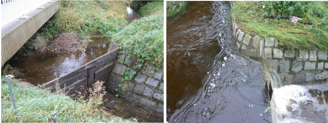
Abbildung 1-6: Teilungsbauwerk Brockwitz nach und während (rechts, Quelle: Stadt Coswig) des HW 2013
