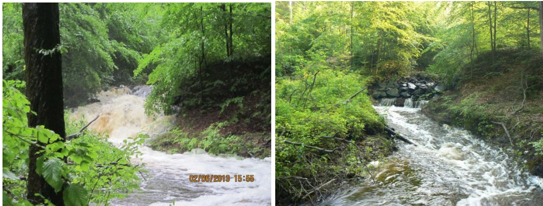
Abbildung 1-21: Unterer Zimmermannscher Teich am 02.06. und 07.06.2013 – tagelanger Abfluss über die Hochwasserentlastung (Quelle: Stadt Coswig)
