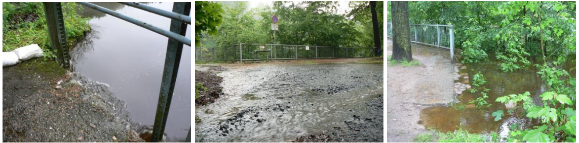
Abbildung 1-19: Spitzgrundteich am 03.06.2013 – Volleinstau und unkontrollierter Überlauf nach Süden zur Spitzgrundstraße (Quelle: Stadt Coswig)
