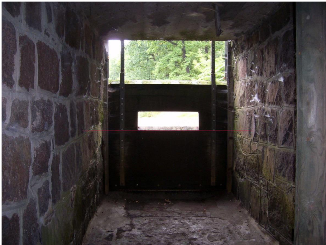
Abbildung 7-4: Geplante neue Oberkante der Wehrtafel (rote Linie) am Spitzgrundteich (Ansicht von der Unterwasserseite)
