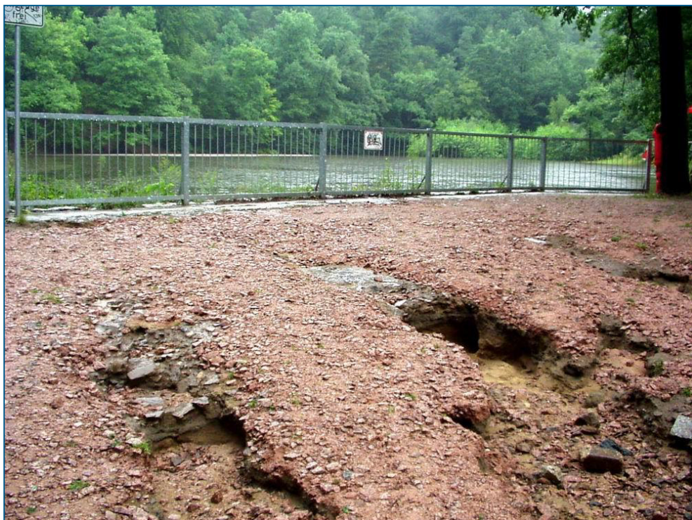
Abbildung 1-10: Durch die seitliche Umströmung der Mauer des Spitzgrundteiches entstandene Auspülungen
